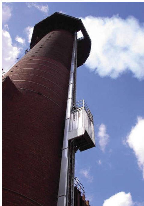
شکل شماره ۱: نمونه‌ای از آسانسور چرخ‌دنده‌ای نصب شده - بلژیک
